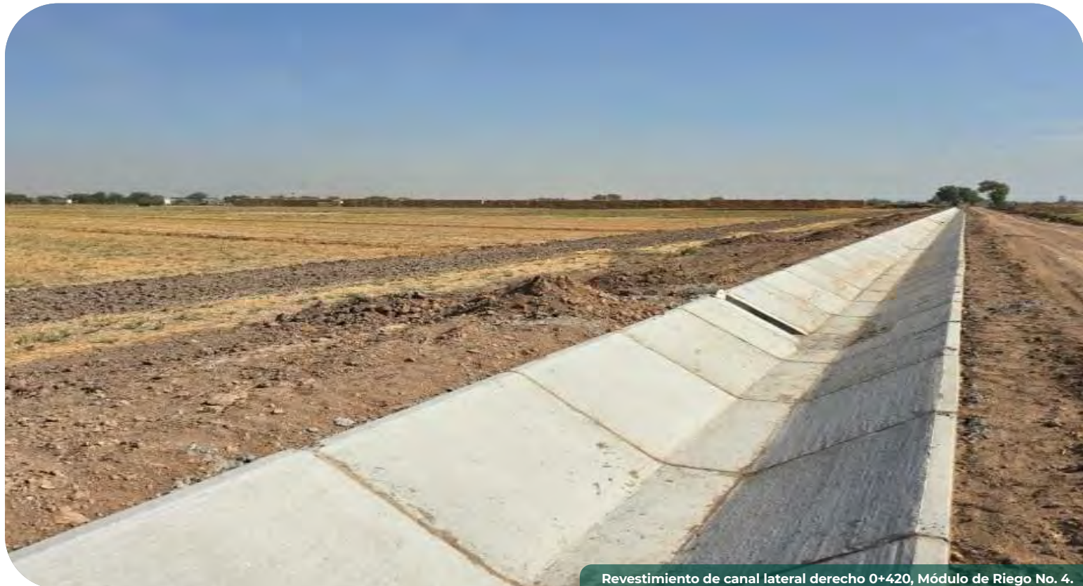
Revestimiento de canal lateral derecho 0+420, Módulo de Riego No. 4.
